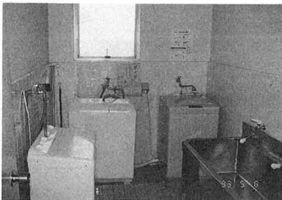
4階の自動洗濯機設置
