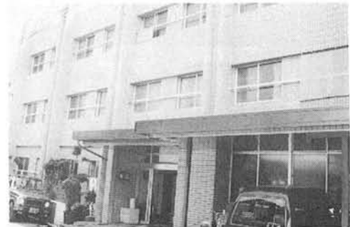
外壁タイル貼り完了
