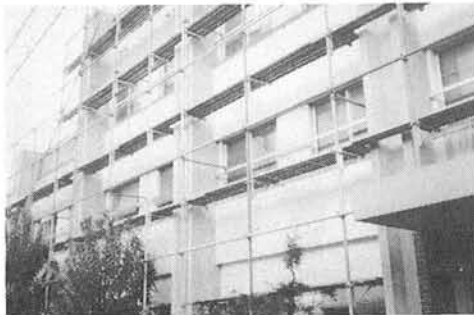
改装中の外壁
