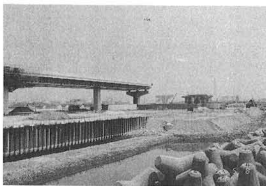
海を埋立て建設中の湾岸道路
